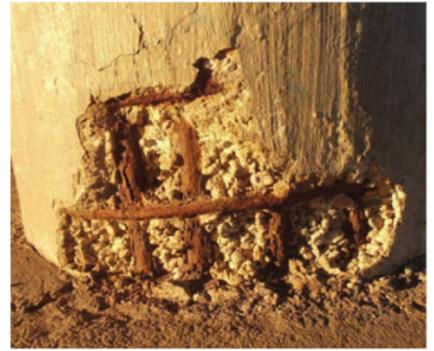
▲ Dégradation d'une pile de pont liée à la corrosion.
