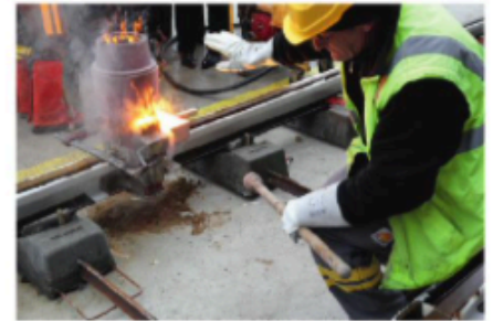
> La transformation étudiée est utilisée pour le soudage des rails.
